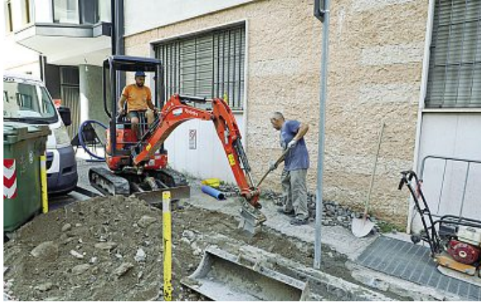
Cantiere Operai al lavoro a Bolzano. Secondo l'Ipl i Comuni dovrebbero appaltare solo ad aziende che pagano il salario minimo
